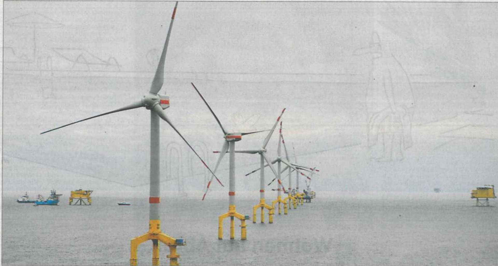
90 Kilometer nordwestlich von Borkum entsteht der Meerespark Bard Offshore I. Er soll künftig Strom für 400 000 Haushalte liefern. Foto: Ingo Wagner/dpa
